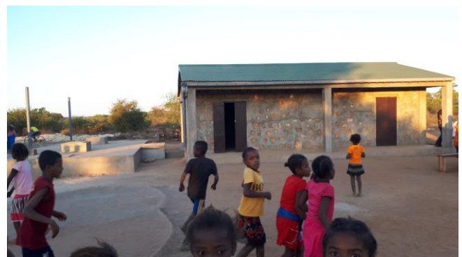
Le chapelle/classe rénovée
